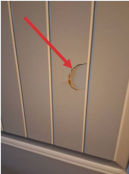
Hallway bedroom door
